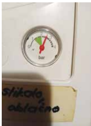
Slika 2: Previsok pritisk na manometru
