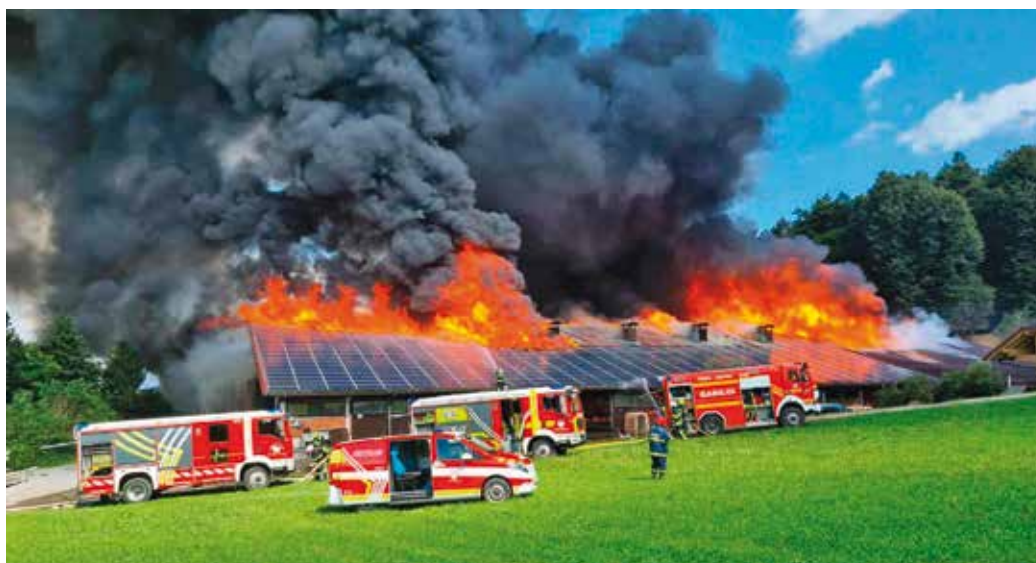
Slika 3: Požar v Zavru pod Šmarno goro, september 2023 (Foto: Občina Medvode/FB) [6]
