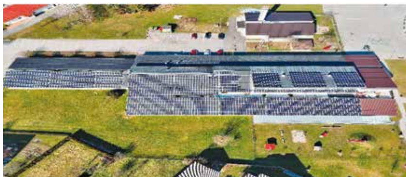
Slika 6: Posnetek strehe OŠ Franja Žgeča Dornava z nameščeno fotonapetostno elektrarno [9]
