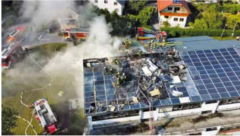
Slika 4: Gašenje požara na šoli (Foto: PGD Bistrica pri Trziču) [6]
